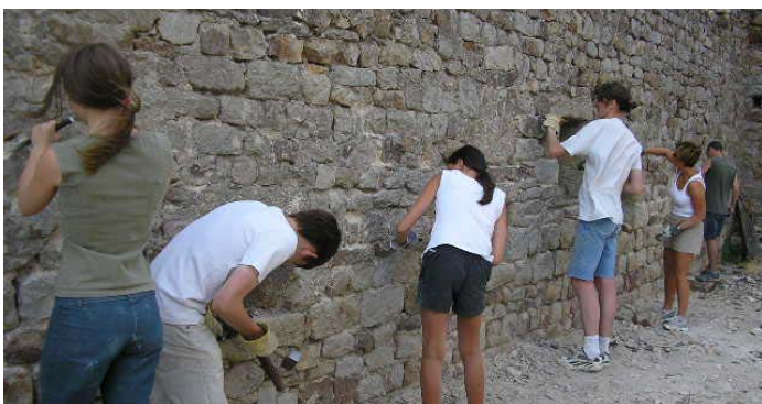
La barbacane lors du décaissage des joints Cl. © Equipe Chantier/RCP - 2005
