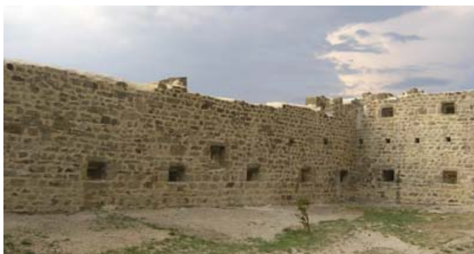
La barbacane après l'intervention des bénévoles Cl. © Equipe Chantier/RCP - 2005
